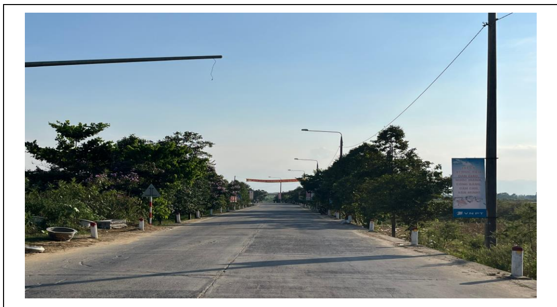
Hình 7. Tuyến đường DT 609 C
